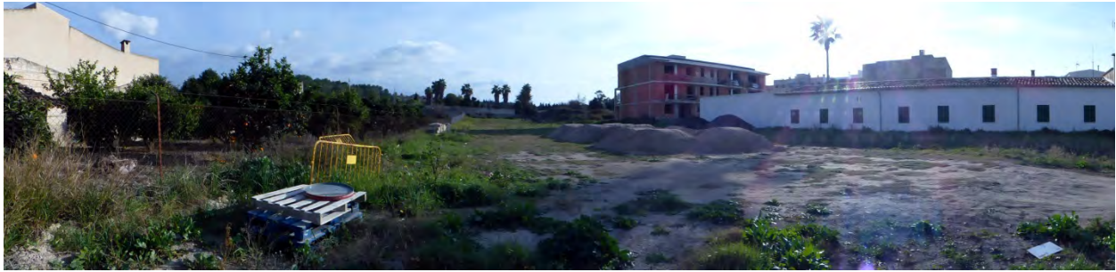
12. Vista des de l'extrem NE cap al SE. En primer terme es veu material de construcció emmagatzemat
