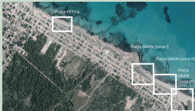
Los trabajos programados están divididos en cuatro zonas, como vemos en la imagen
